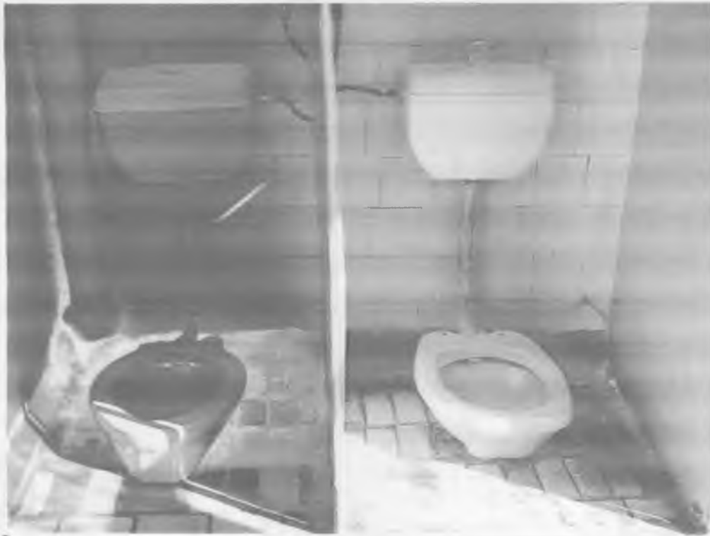
Фото №13 Туалетная комната
